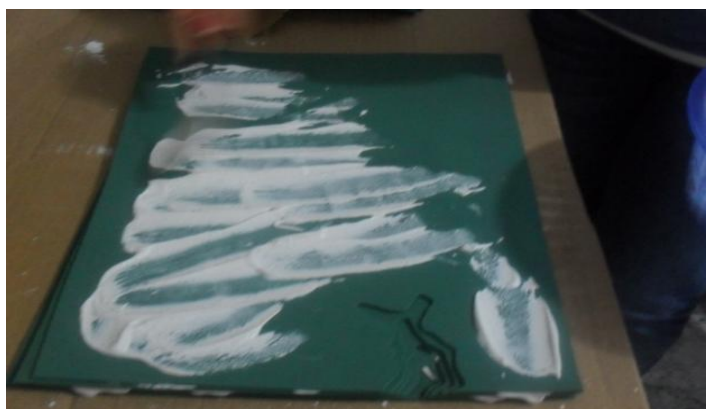
Figura 09 - Fixação das placas com gesso.
